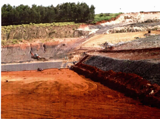
Figura 26. Aterro Sanitário – SIL Soluções Ambientais – Minas do Leão/RS
