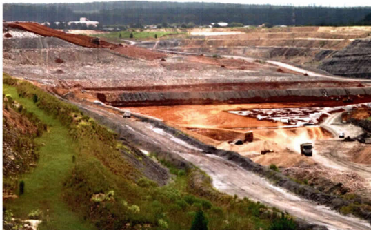
Figura 24. Aterro Sanitário – SIL Soluções Ambientais – Minas do Leão/RS
