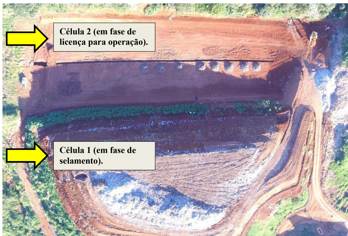
Figura 21 - Células do aterro sanitário.
