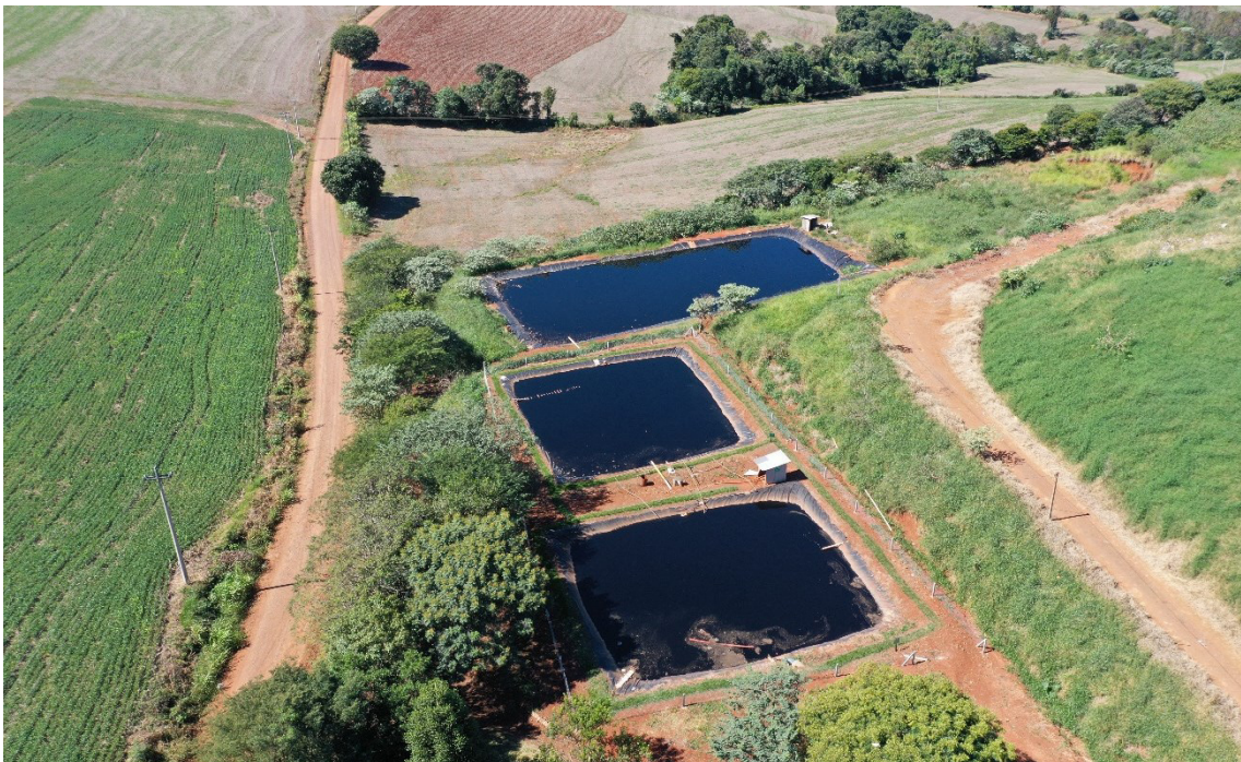
Figura 20 - Estação de tratamento de efluentes líquidos.
